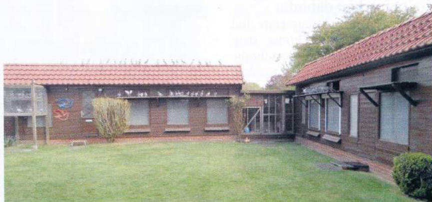
Die im Winkel gebaute Schlaganlage ist 30 Meter lang und in acht Abteile unterteilt. 35 Weibchen und etwa 60 Jungtauben gehen von hier auf die Reise.
